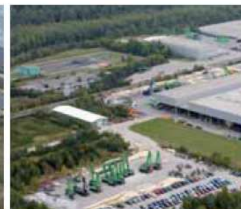
3 Werk Wackersdorf, seit 1991, Works Wackersdorf, since 1991,
