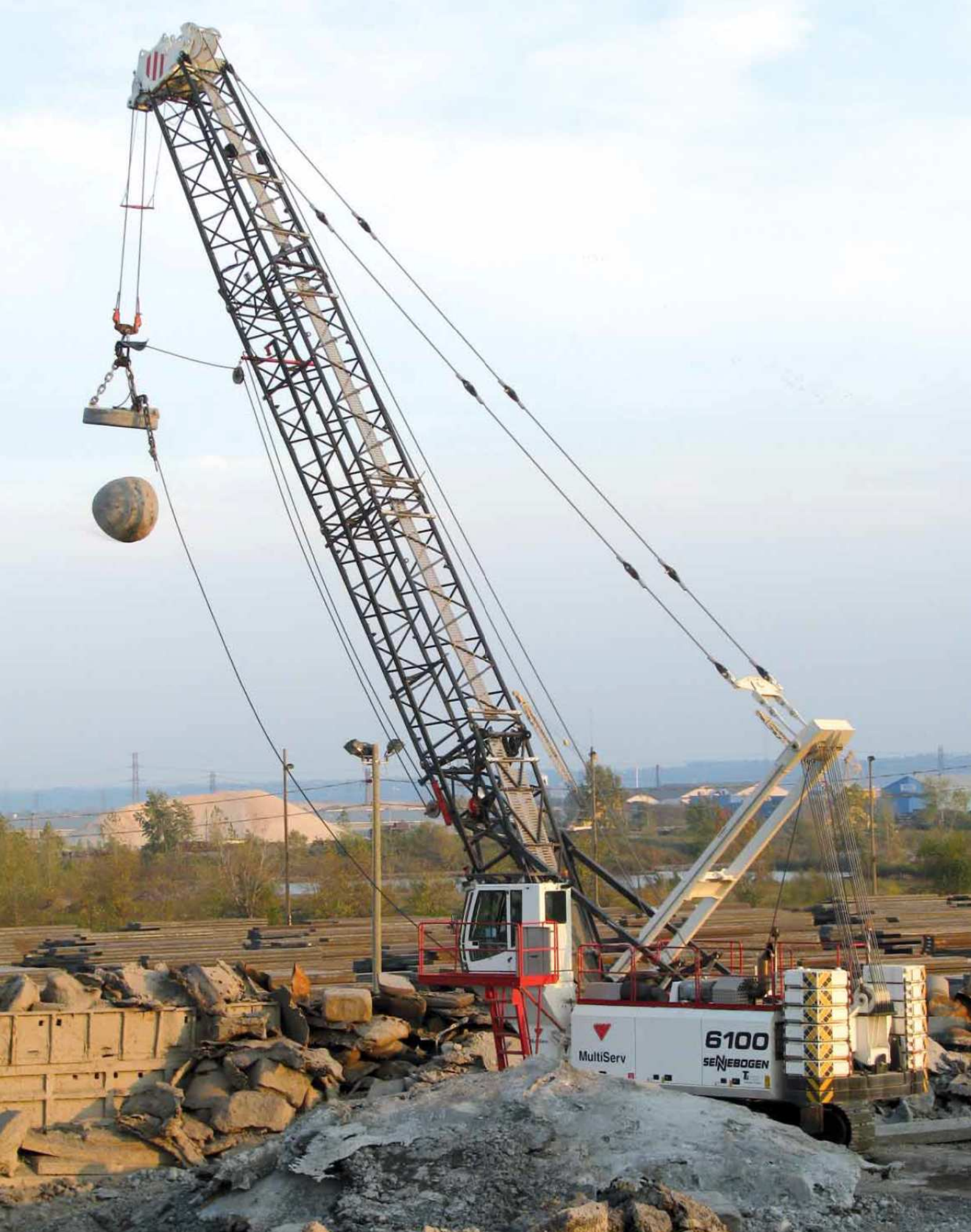
6100 HD - 24,3 m Auslegerlänge - Schlackezerkleinerung mit Magnetplatte - Kanada 6100 HD - 24.3 m boom length - slag crushing with magnet plate - Canada
