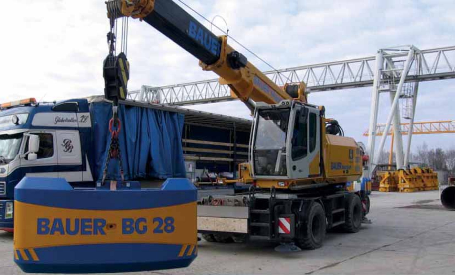
643 MI Telescopic Mobile Crane - hoist and moving of counter weight; Germany 643 MI Teleskopmobilkran - Heben und Verahren eines Heckgewichts; Deutschland
