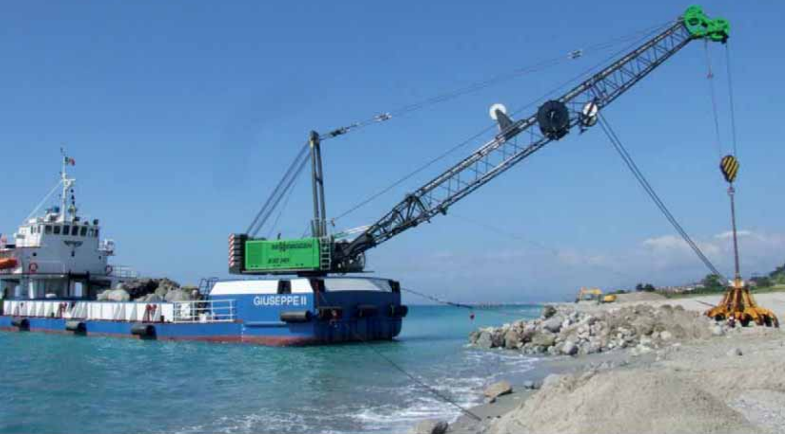
690 HD Duty Cycle Crane - coastal protection; Italy 690 HD Selbstagger - Küstenschutz; Italien
