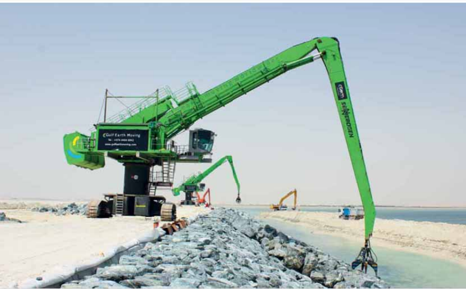
880 EQ - Coastal fortification works with special grab; Qatar 880 EQ - Küstenbefestigungsarbeiten mit Spezialgreifer; Katar
