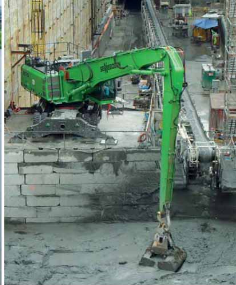
870 Mobile - dredging works in a trailing pond (slick handling); USA 870 Mobil - Ausbaggern eines Schleimbeckens (Trallings); USA
