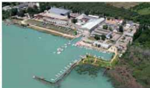
Factory Balantonfüred/Hungary – welding/steel construction Werk Balantonfüred/Ungarn – Schweiß-/Stahlbaugruppen
