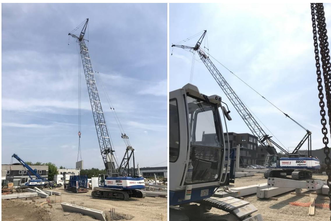
Les grues SENNEBOGEN 2200R à flèche treillis et 643R à flèche télescopique se complètent sur le chantier
