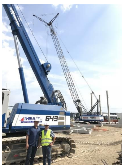
Benôit Thibault et son conducteur de travaux Laurent VAURIS veillent à l'organisation millimétrée des chantiers de constructions préfabriquées
