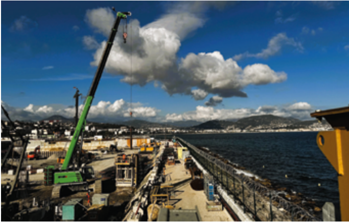
Haliotis 2 se trouve en front de mer, ce qui implique d'ancrer la digue de protection du site sur un linéaire de 500 m par 82 barrettes profondes de 40 m !
