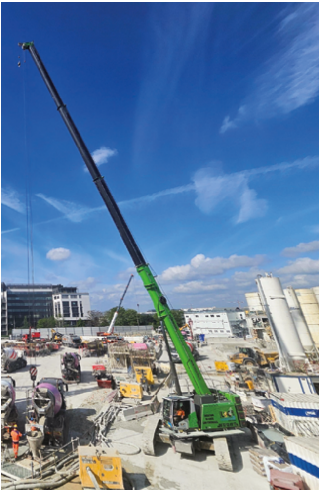
La gare des Grésillons et celle de Bois-Colombes sont deux morceaux de bravoure de ce lot de la ligne 15 entre La Défense et Saint-Denis-Pleyel. Pour garantir leur étanchéité dans des terrains largement perméables et fracturés, des campagnes d'injections profondes suivies d'ancrage de parois à 70 m de profondeur sont nécessaires.
