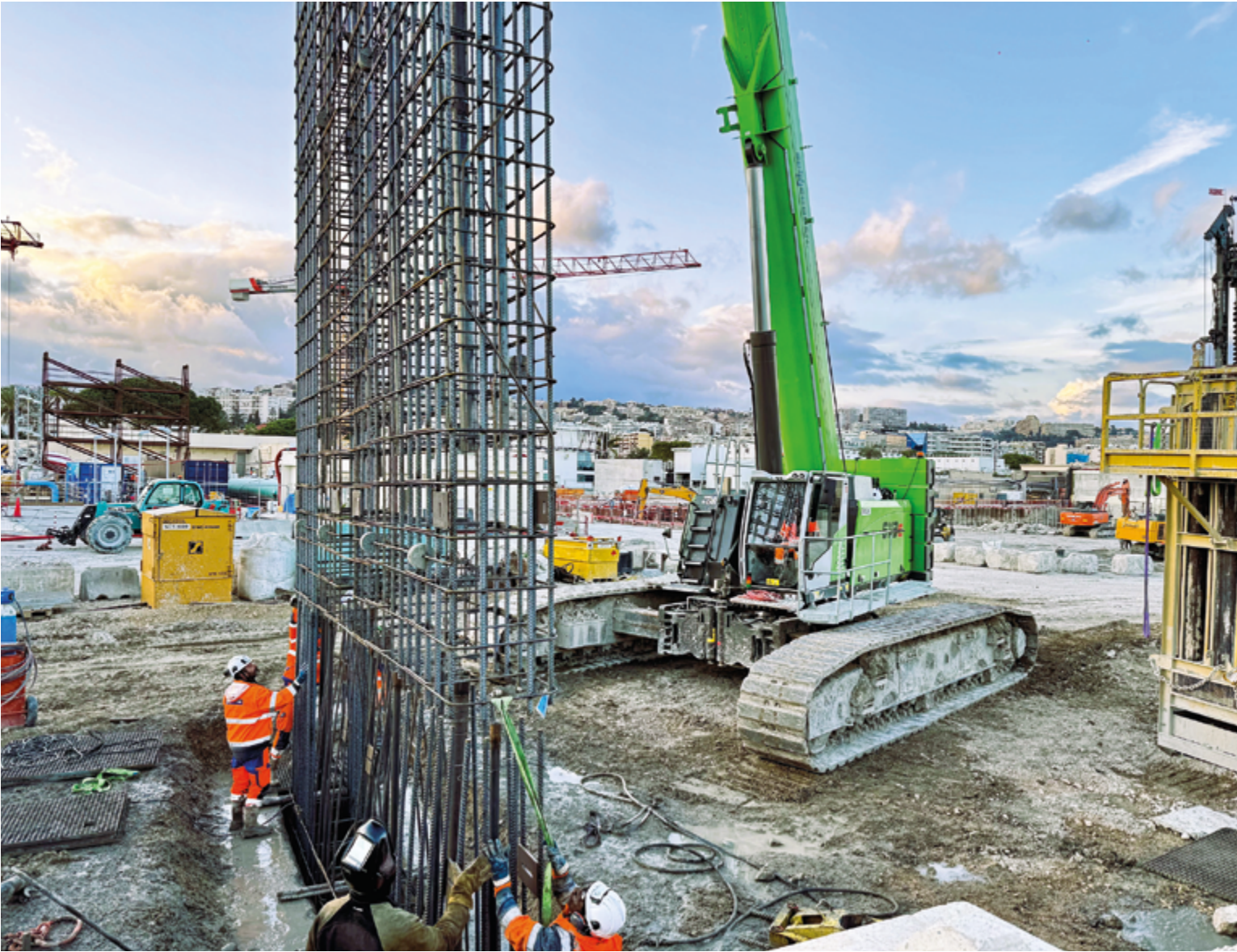
Les éléments de la cage sont soudés à l'avancement de la descente par une équipe dédiée, avec un jointement prévu à cet effet.
