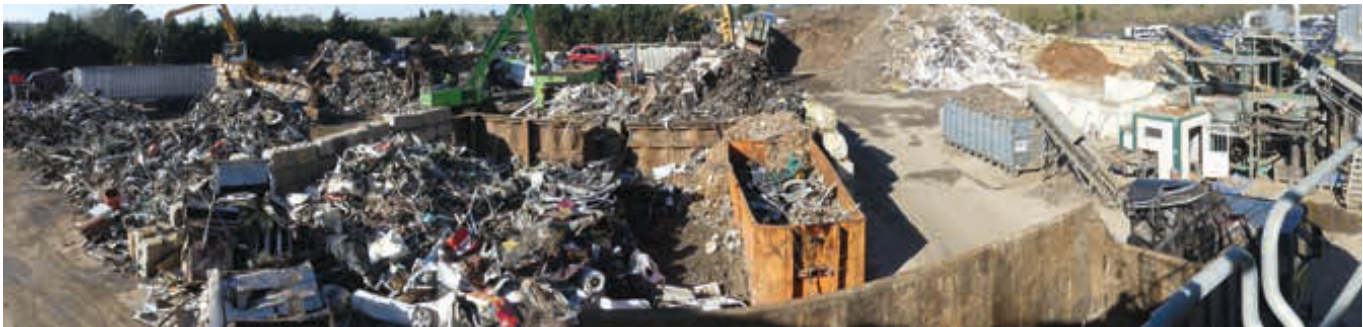
^ Coutras rassemble les outils de préparation et de transformation comme la découpe au chalumeau, l'atelier de cisailage, une ligne de grenailage et un atelier de dépollution de VHU.
