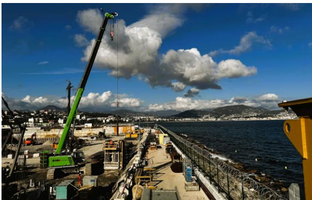
Opérations de dessablage des boues de forage avant de mettre en place les cages d'armature
