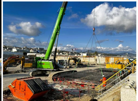
La grue télescopique sur chenilles SENNEBOGEN 6113E assure la manutention, le relevage, l'approche en pick&carry (déplacement en charge) et la mise en place des cages d'armature
