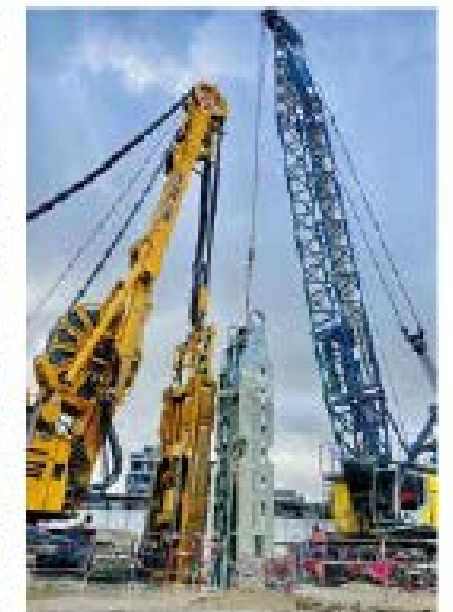
En face à face une pelle à câble en excavation benne à parois, et une hydro-haveuse qui excave et qui bétonne en même temps.
