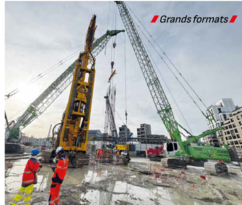
La grue sur chenilles Sennebogen 3300 de l'entreprise Force-Loc assure les mises en place de cages d'armature sur le chantier de lancement du tunnelier « Les Caboeufs » à Gennevilliers.
