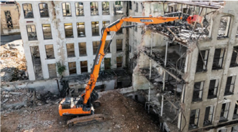
La plupart des marques ont des modèles de démolitions dans leur gamme. Pour d'autres, ce sont généralement des adaptations lourdes de modèles de terrassement.
