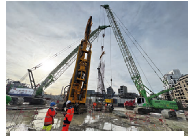
La 3300 de l'entreprise Force-Loc assure les mises en place de cages d'armature sur le chantier de lancement du tunnelier « Les Cabœufs »
