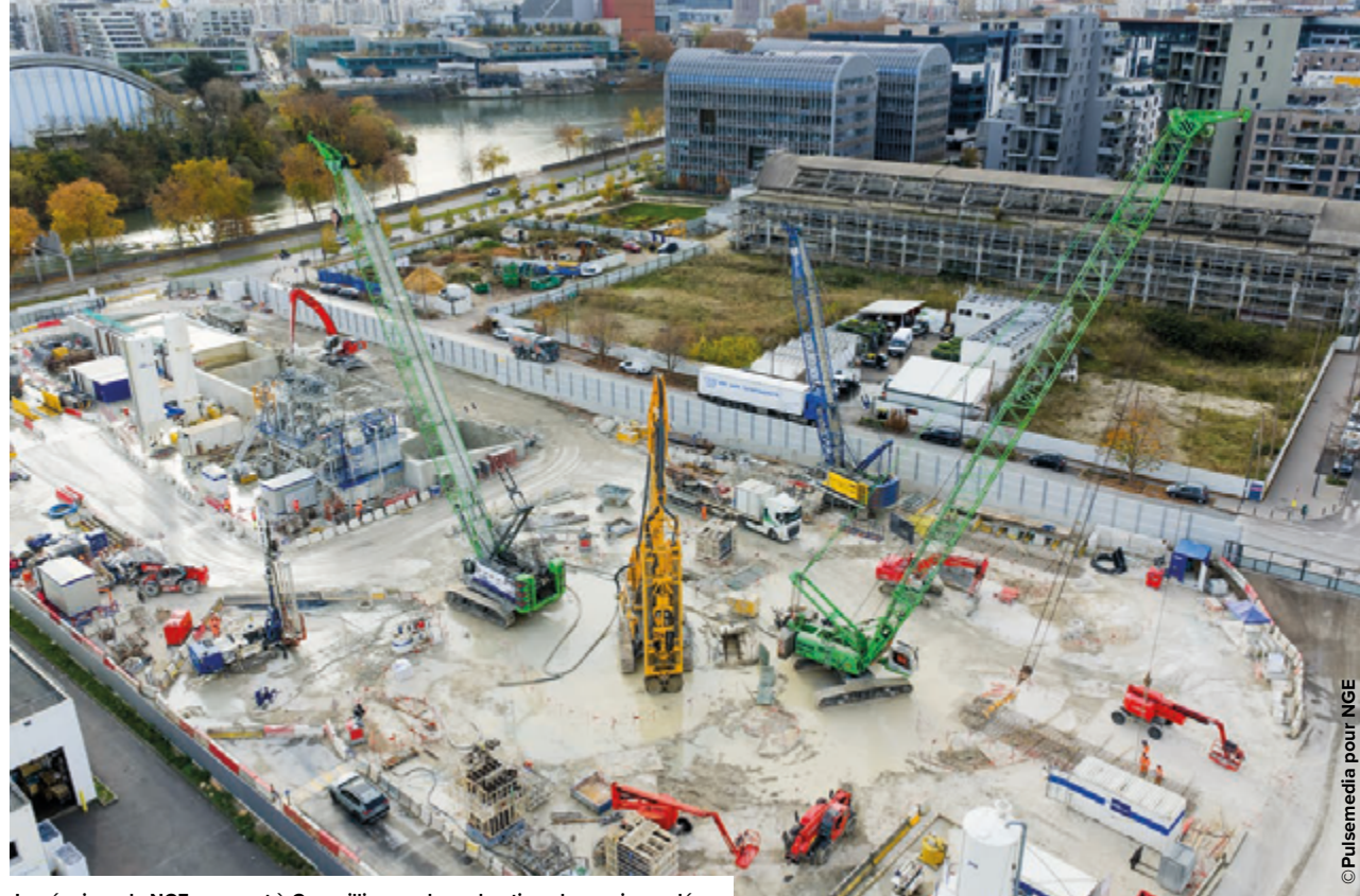
Les équipes de NGE oeuvrent à Gennevilliers sur deux chantiers de parois moulées.
