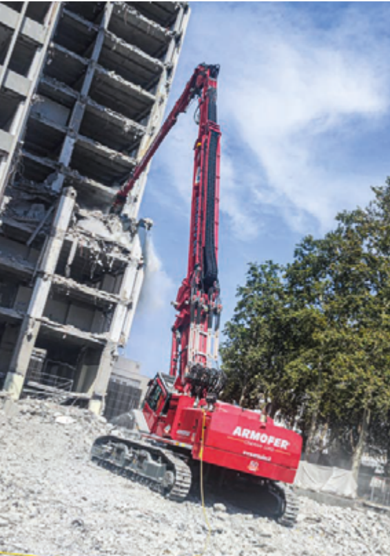
La plupart des marques ont des modèles de démolitions dans leur gamme. Pour d'autres, ce sont généralement des adaptations lourdes de modèles de terrassement.
