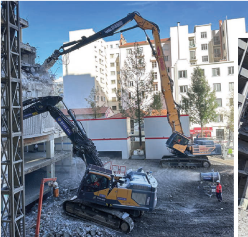
La plupart des marques ont des modèles de démolitions dans leur gamme. Pour d'autres, ce sont généralement des adaptations lourdes de modèles de terrassement.
