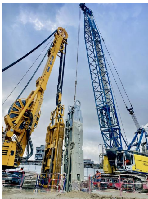
Les pelles à câbles SENNEBOGEN sur le chantier de lancement du tunnelier « Les Cabœufs » à Gennevilliers : la 6130HD en forage à la benne à parois, en tandem avec une hydro-haveuse, et la 6140HD en manutention lourde
