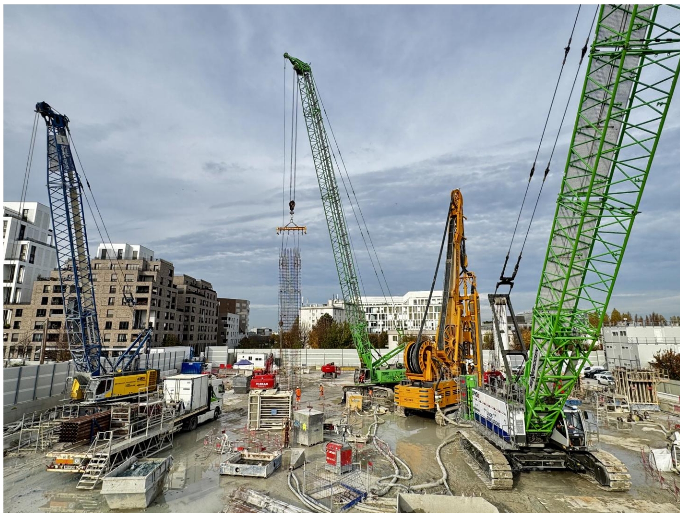
Trio de grues et pelles à câbles SENNEBOGEN sur le chantier de lancement du tunnelier « Les Cabœufs » à Gennevilliers : la 6130HD en forage à la benne à parois, en tandem avec une hydro-haveuse, la 6140HD en manutention lourde, et la grue 3300 en opérations de levage de cages d'armature
