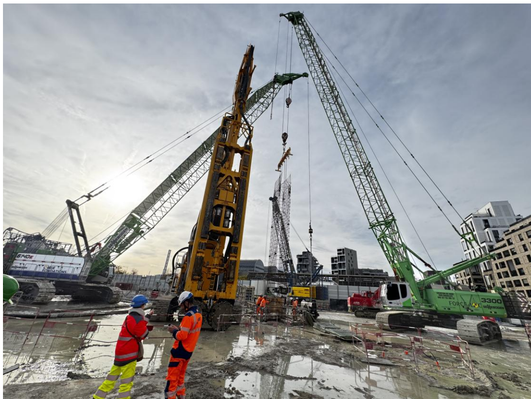
La grue sur chenilles SENNEBOGEN 3300 de l'entreprise FORCE-LOC assure les mises en place de cages d'armature sur le chantier de lancement du tunnelier « Les Cabœufs » à Gennevilliers
