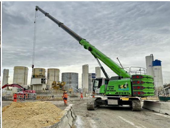
La grue télescopique sur chenilles SENNEBOGEN 673E assiste les opérations de bétonnage, de préparation des cages d'armature et les manutentions diverses sur le chantier de la gare Les Grésillons à Gennevilliers
