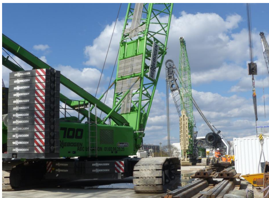
La grue sur chenilles SENNEBOGEN 7700R-SL, d'une capacité de 300t, assure les levages et manutentions de cages d'armatures
