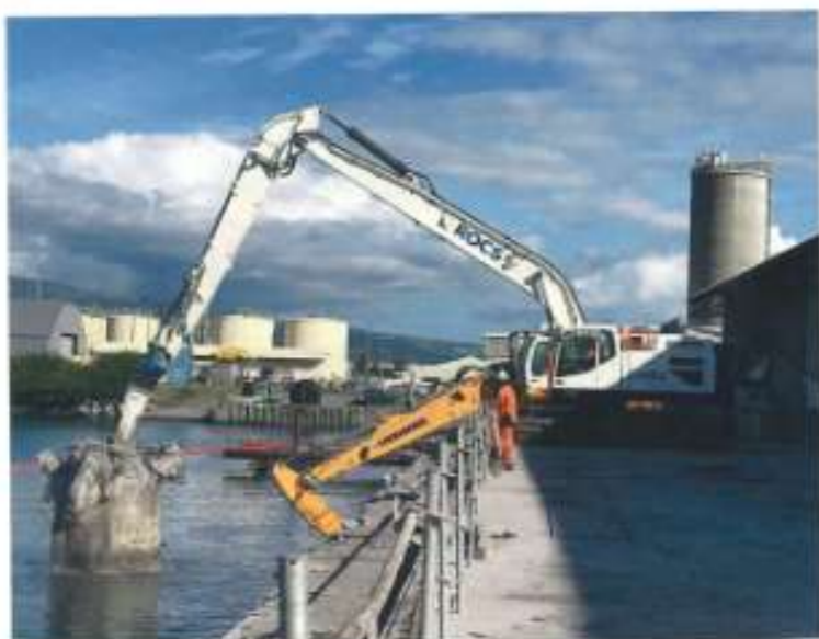
Démolition des piles.
