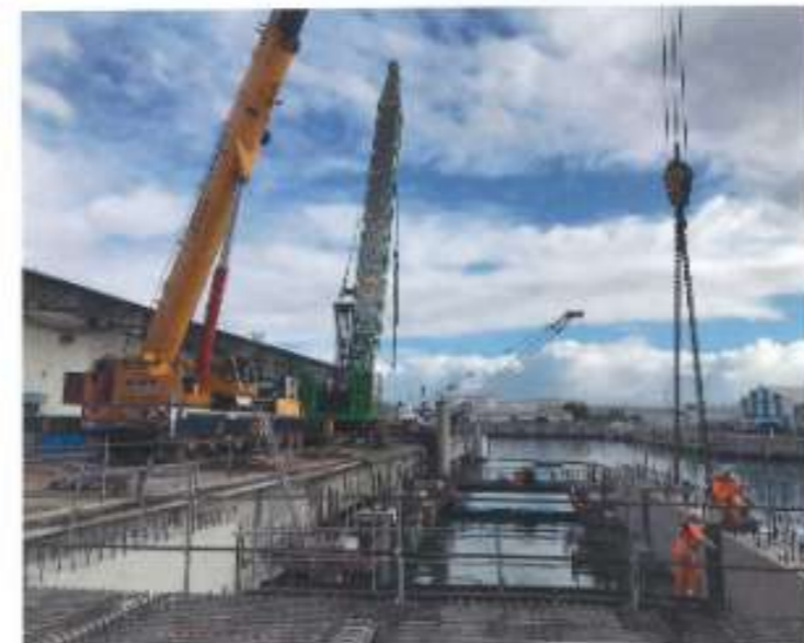
Mise en place des poutres longitudinales.
