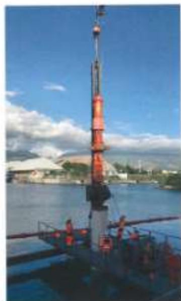
Phase de battage des pieux.
