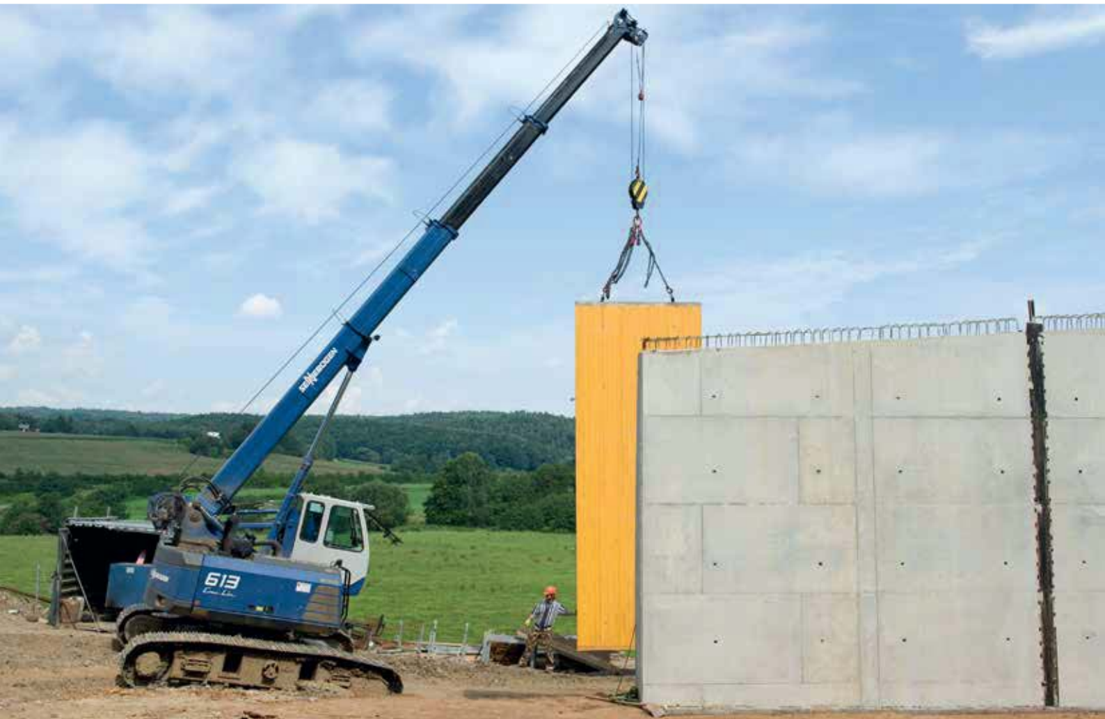
613 R - work under load, even in inclined position, increases flexibility on every construction site; Germany 613 R - verfahren unter Last auch in Schrägstellung erhöht die Flexibilität auf jeder Baustelle; Deutschland
