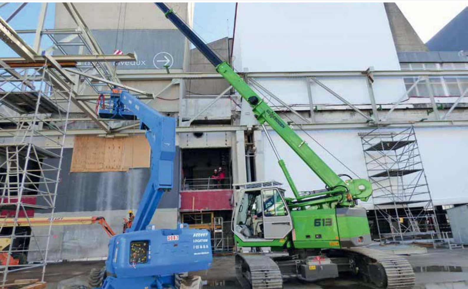
613 R - assembly in industrial and structural engineering; France 613 R - Montage im Industrie- und Hochbau; Frankreich
