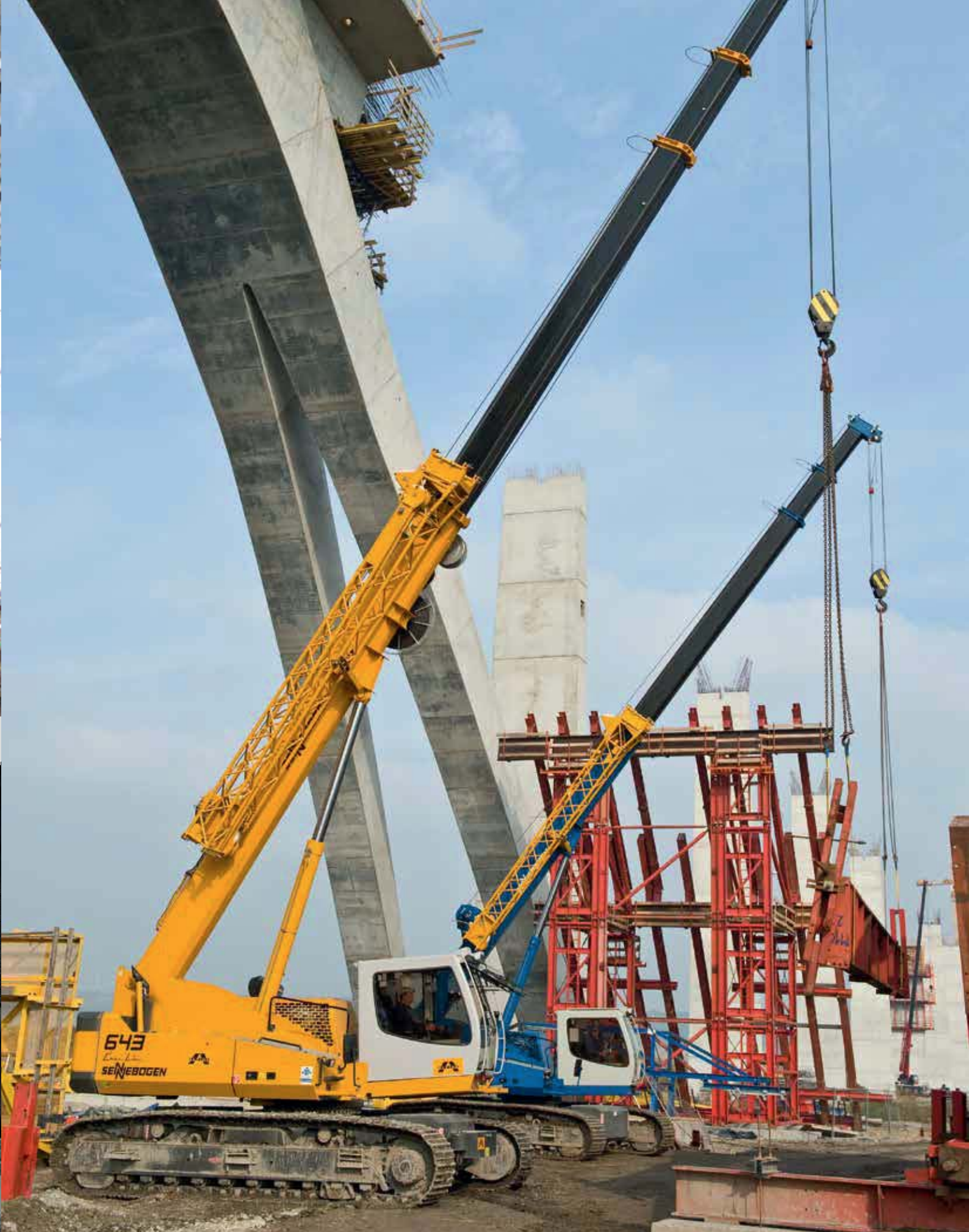
643 R - reliable even in tandem lift; Germany 643 R - zuverlässig auch im Tandemhub; Deutschland
