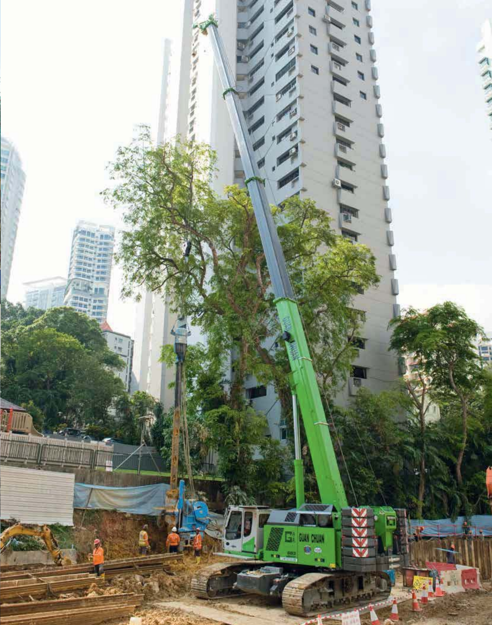
683 R - at foundation engineering with drill leader; Singapore 683 R - im Spezialtiefbau mit Bohrmäkler; Singapur
