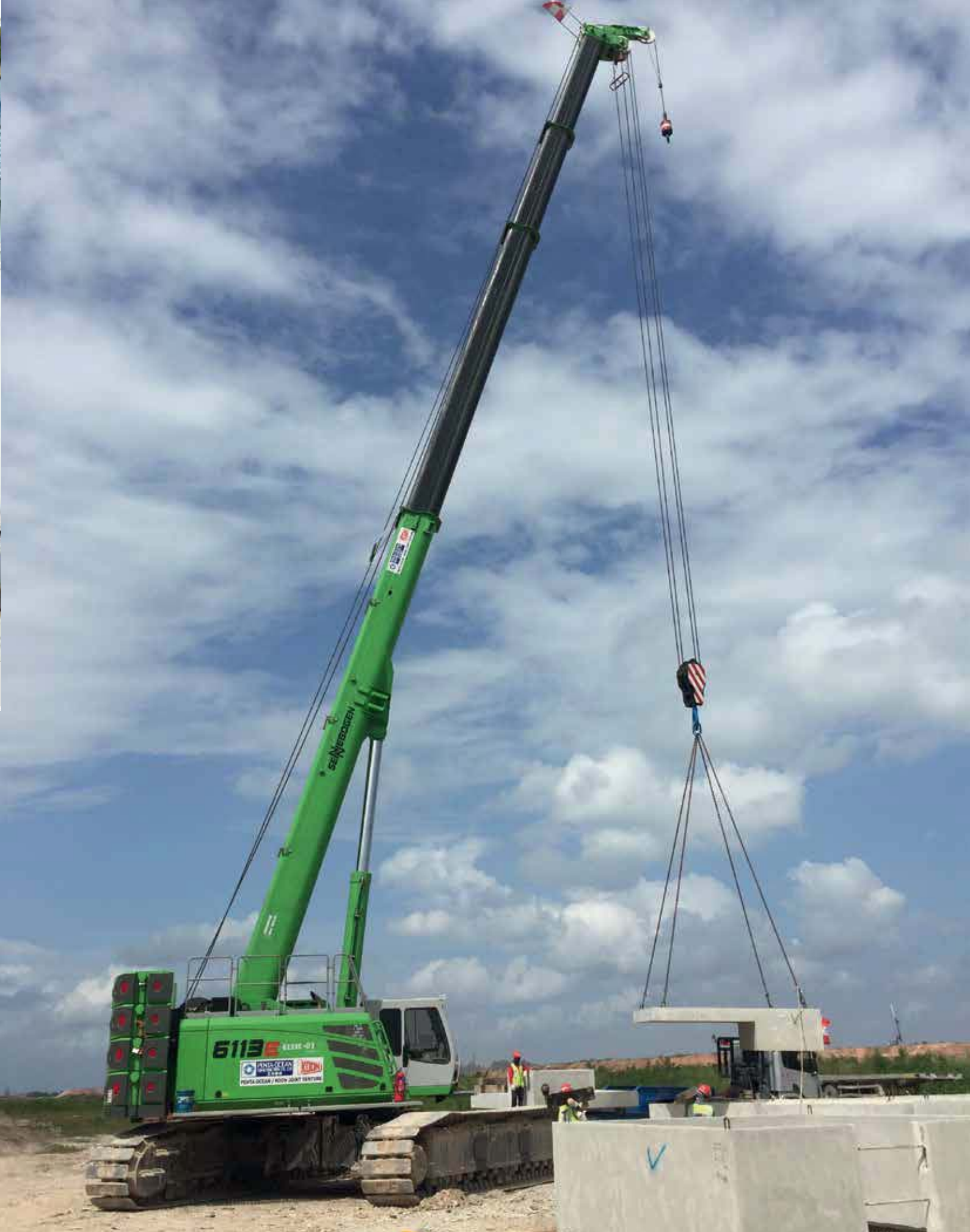
6113 R - truck loading and unloading with precast concrete parts; Singapore 6113 R - LKW Be- und Entladung mit Beton-Fertigteilen; Singapur
