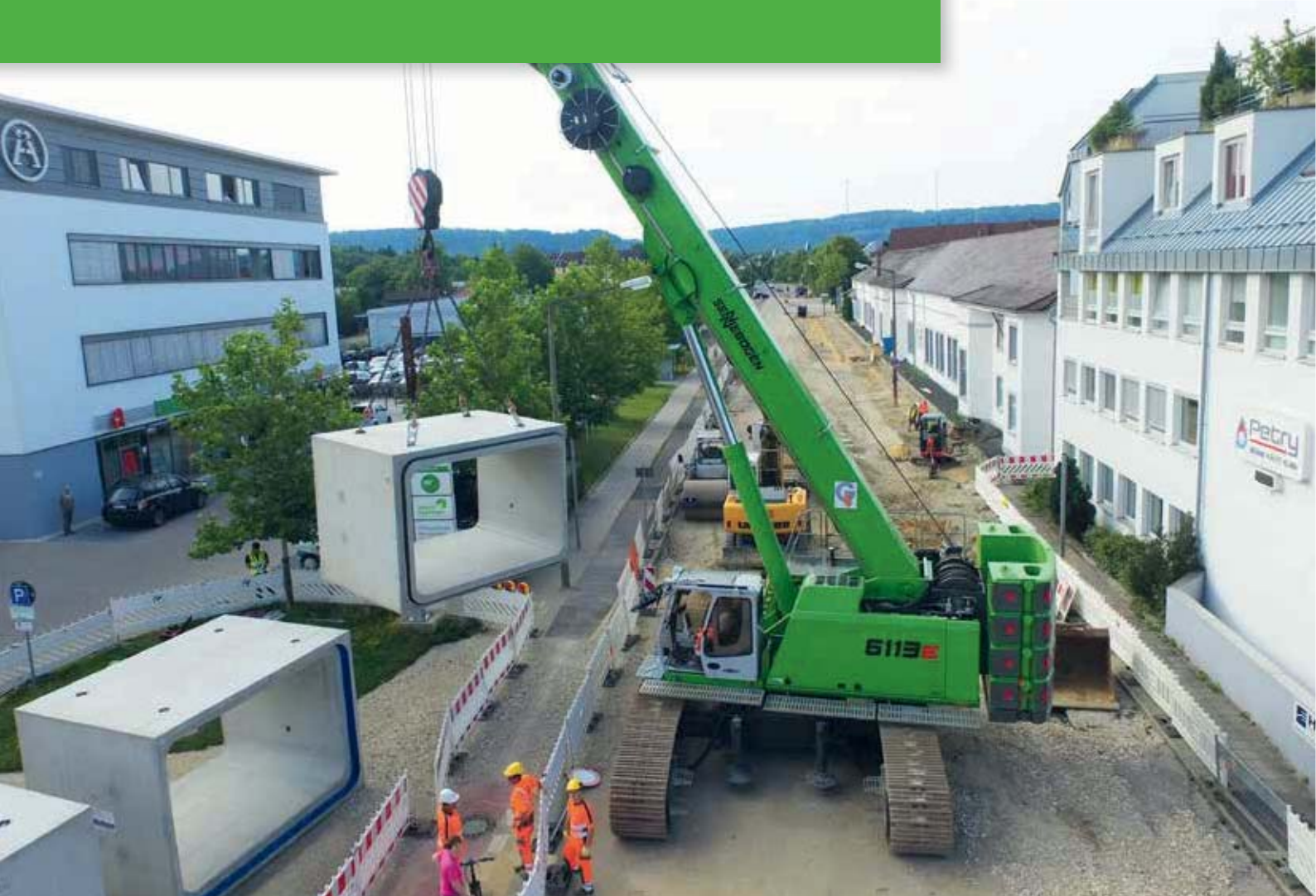
6113 R - moving and positioning large and heavy components in civil engineering; Germany 6113 R - große und schwere Komponenten verfahren und positionieren im Tiefbau; Deutschland
