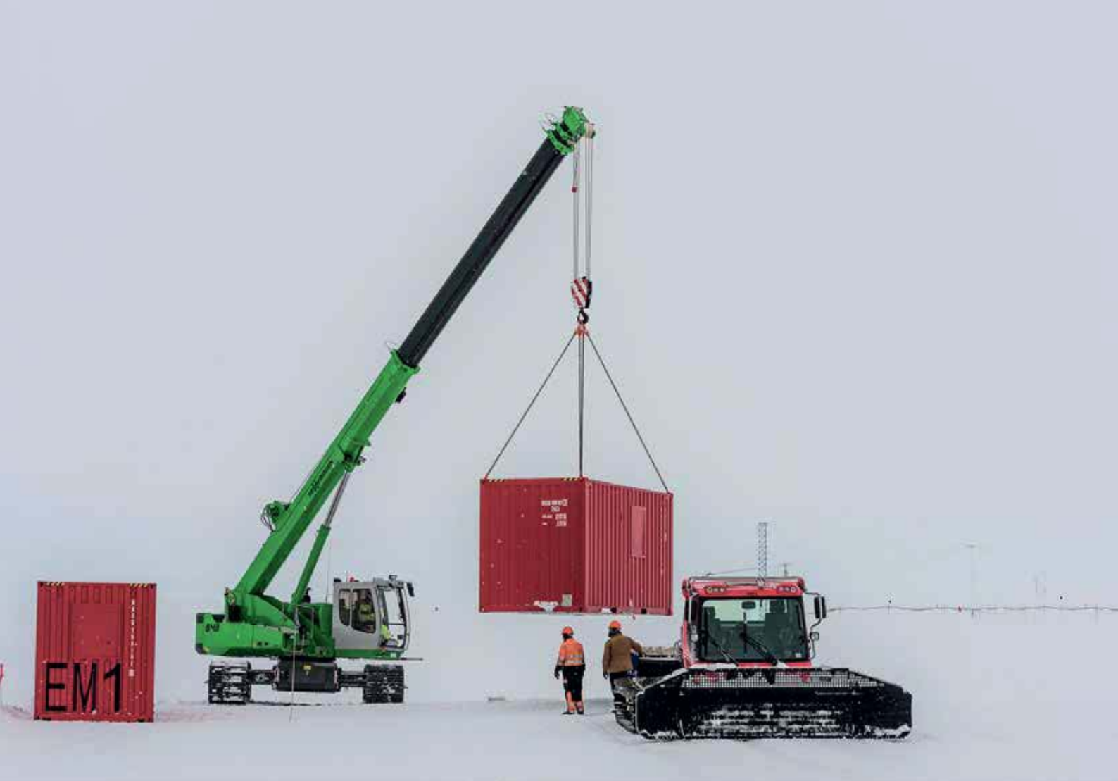
643 R - use in low-temperature as a service crane; Antarctic 643 R - im Tieftemperatureinsatz als Service-Kran; Antarktis
