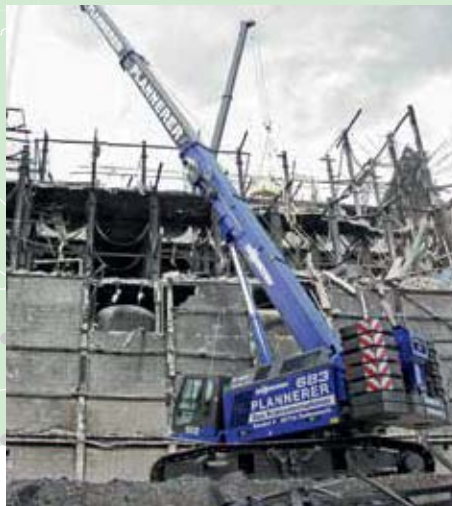
Demolition & Dismantling Abbruch & Rückbau
