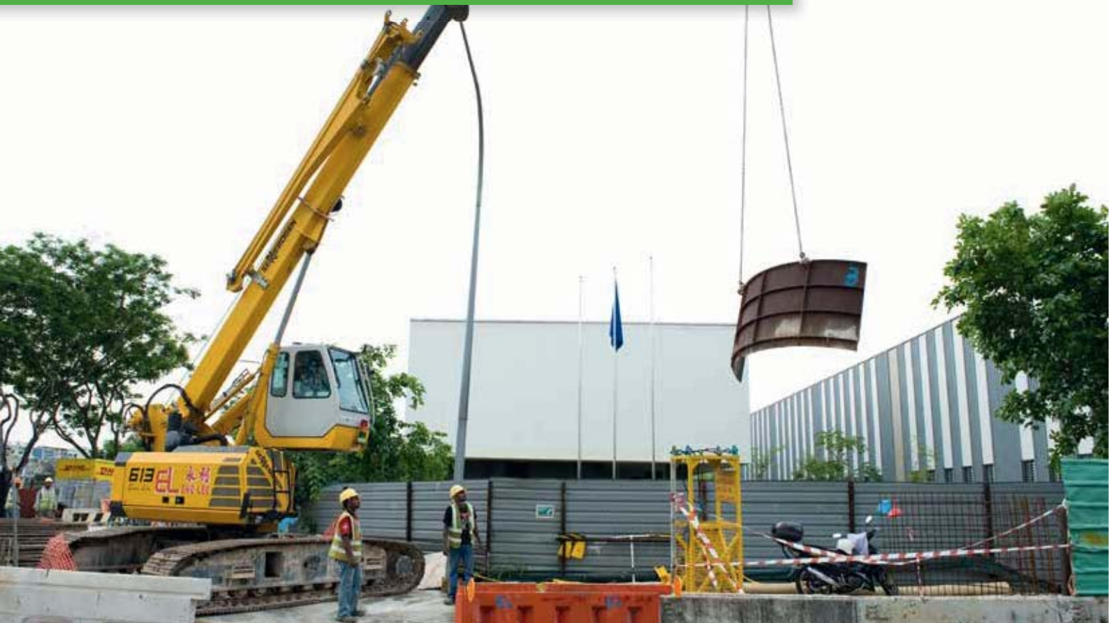
613 R - lifting tasks in confined spaces on urban construction sites; Singapore 613 R - Hebearbeiten auf engem Raum auf städtischen Baustellen; Singapur
