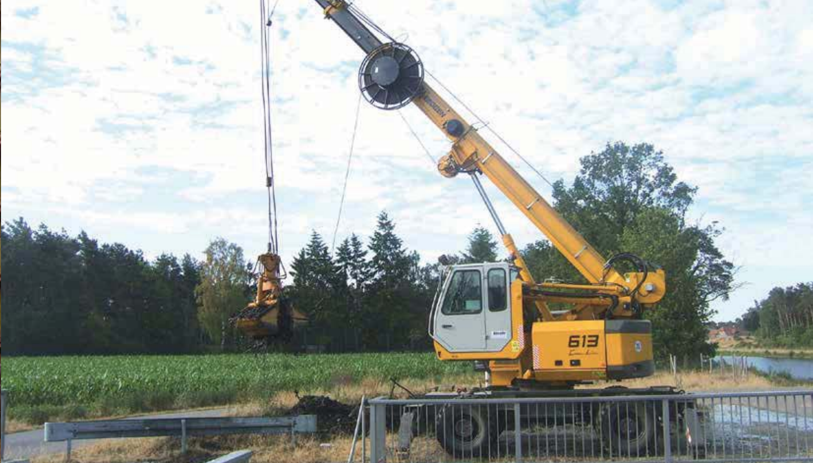
613 M – clamshell operation in hydraulic engineering; Germany 613 M – Zweischalengreifereinsatz im Wasserbau; Deutschland
