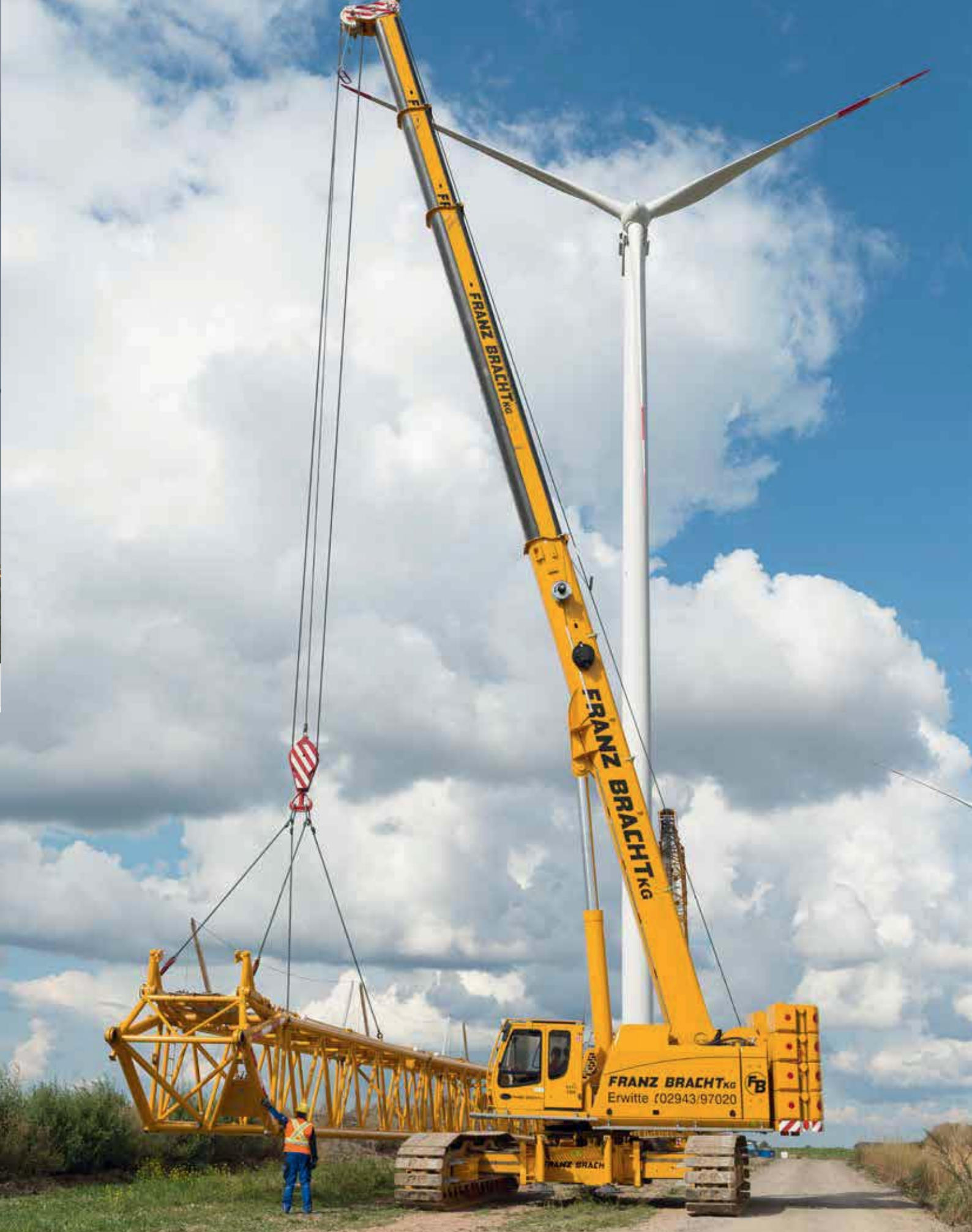
6113 R - used as a flexible service crane in wind energy; Germany 6113 R - im Einsatz als flexibler Service-Kran in der Windenergie; Deutschland
