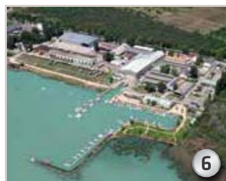
Works Balantonfüred, Hungary: Welding/steel structures Werk Balantonfüred/Ungarn: Schweiß-/Stahlbaugruppen
