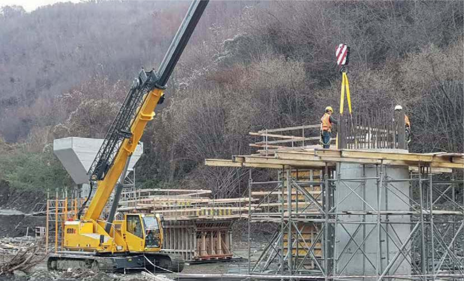
633 R - hoisting crane on difficult terrain in bridge construction; Kosovo 633 R - Hebekran auf schwierigem Untergrund im Brückenbau; Kosovo
