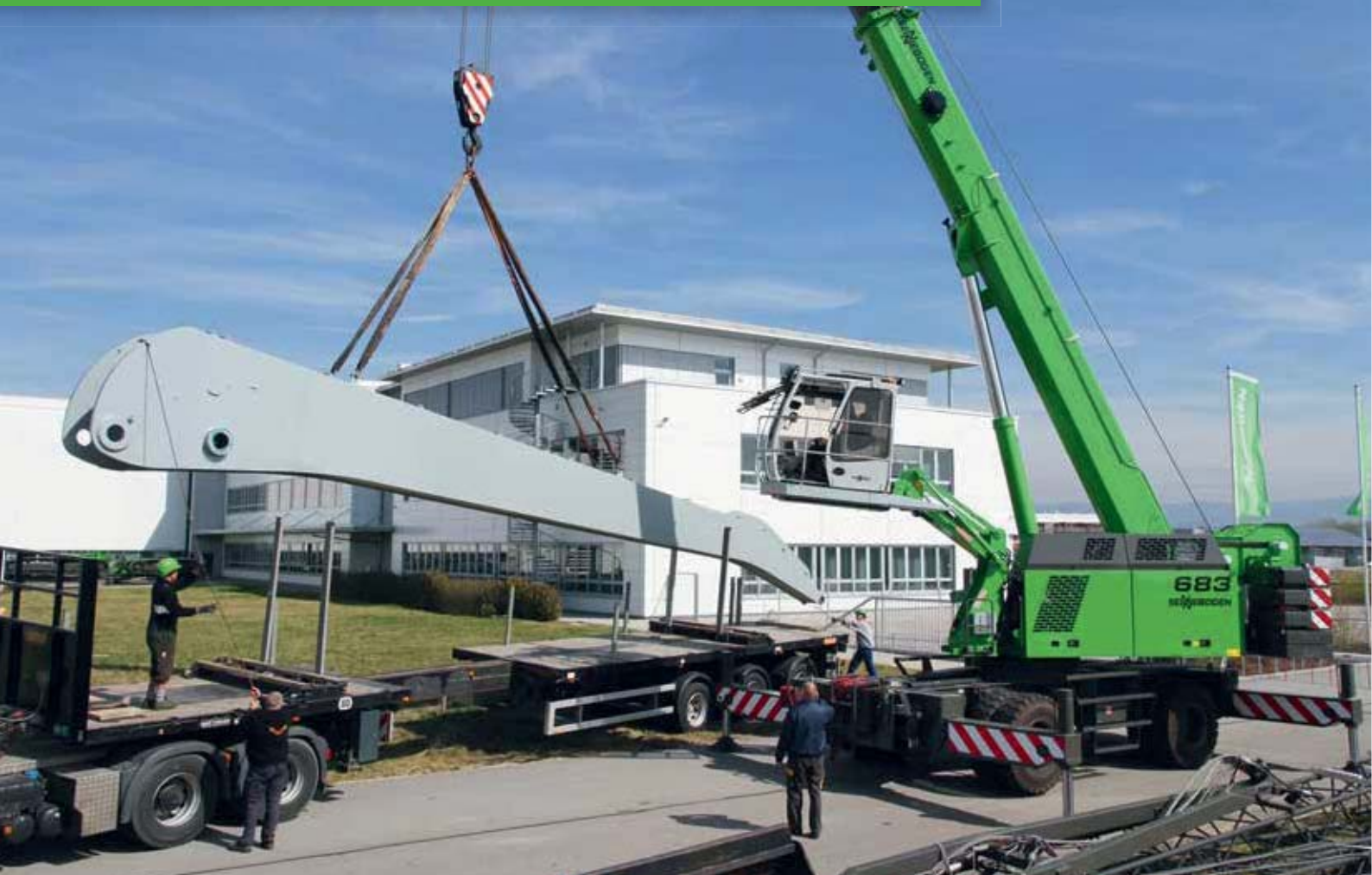
683 M - use as storage yard crane; Germany 683 M - Einsatz als Lagerplatzkran; Deutschland
