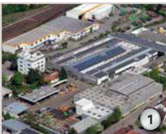
Works 1, Straubing: Company headquarter Werk 1, Straubing: Unternehmenssitz
