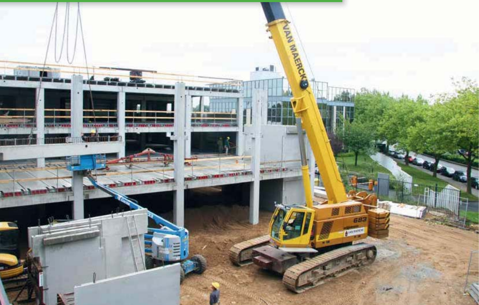
683 R - lifting, moving and positioning precast concrete elements; Netherlands 683 R - Betonfertigteile heben, verfahren und positionieren; Niederlande
