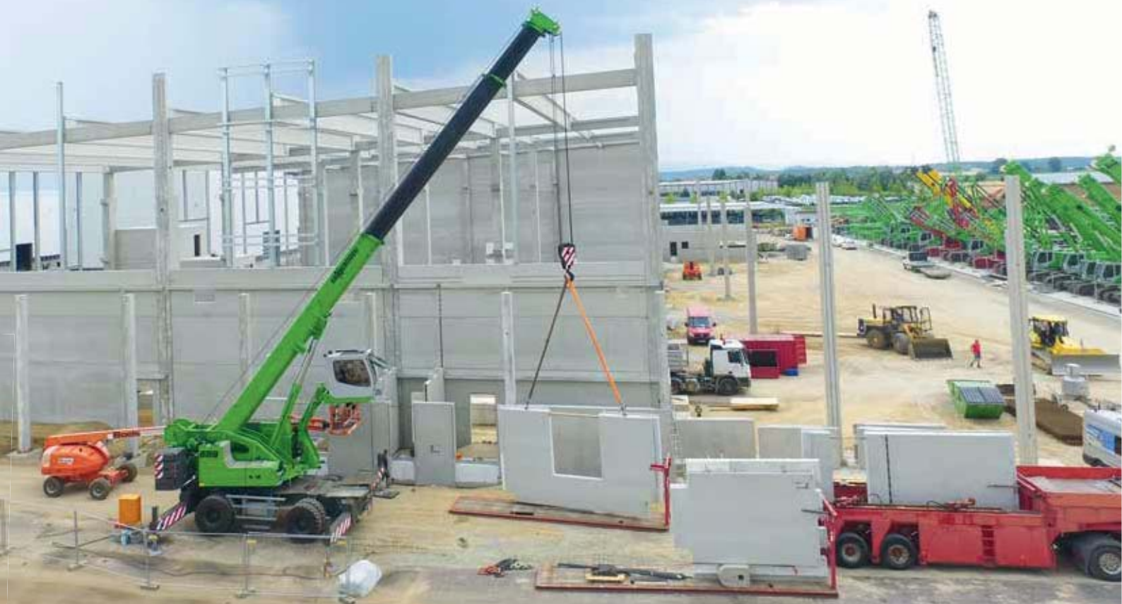
683 M - hoisting works of concrete-prefabricated parts in building industrial works; Germany 683 M - Fertigbetontteile in Industrie- und Hallenbau sicher heben; Deutschland
