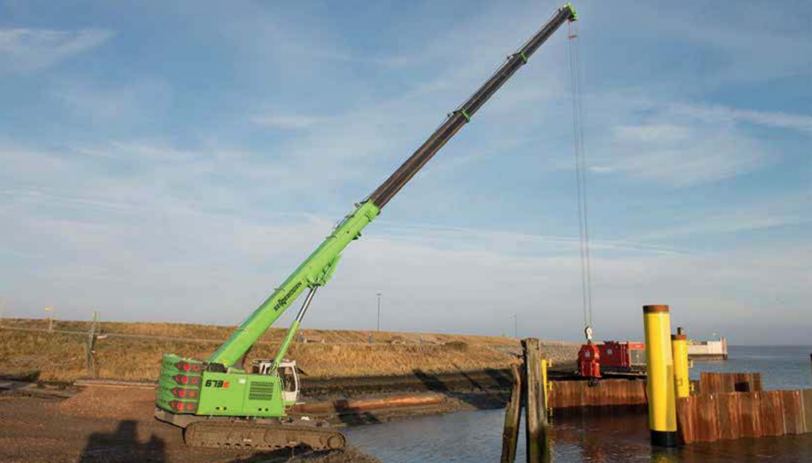
673 R - working safely, even in an inclined position using agitator; Germany 673 R - sicher Arbeiten auch in Schräglage mit Rüttler; Deutschland
