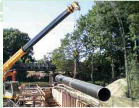
Pipe installation works Rohrlegearbeiten
