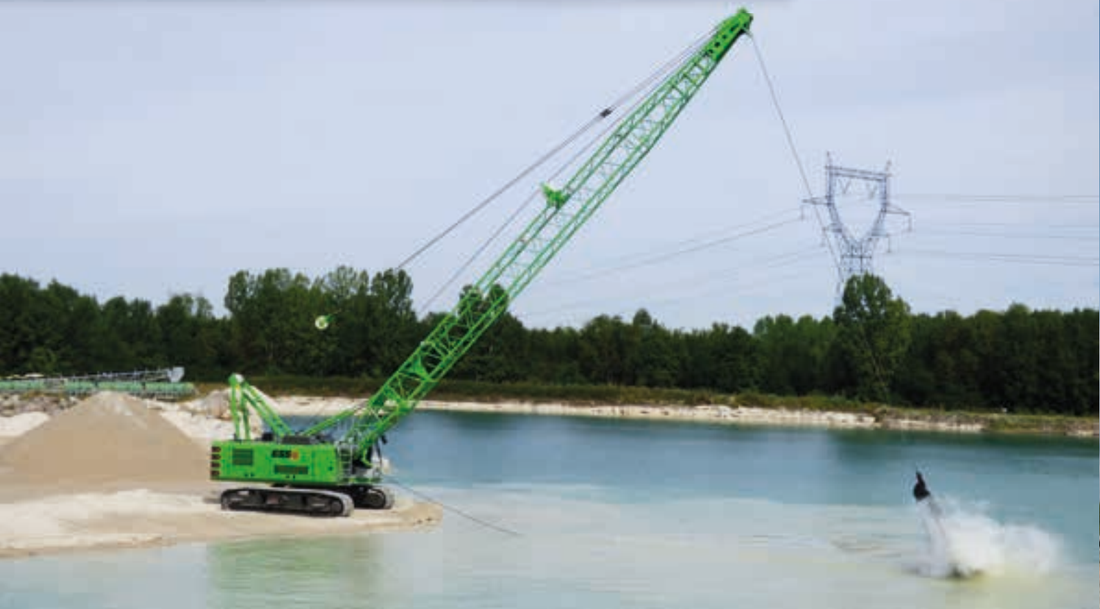
655 HD – Gravel quarrying with dragline bucket; France 655 HD – Kiesgewinnung mit Schleppschaufel; Frankreich
