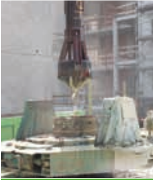
Casing Oscillation Verrohrung 36 - 41
