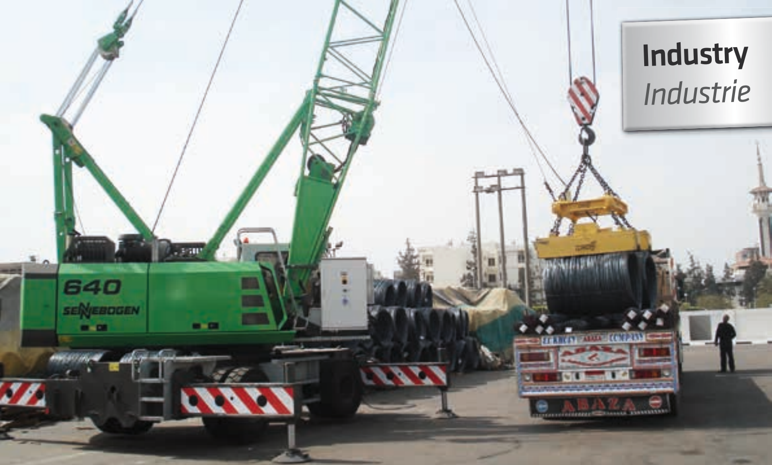
640 Mobile – Hook operation with magnet plate, Egypt 640 Mobil – Kraneinsatz mit Magnethalter, Ägypten
