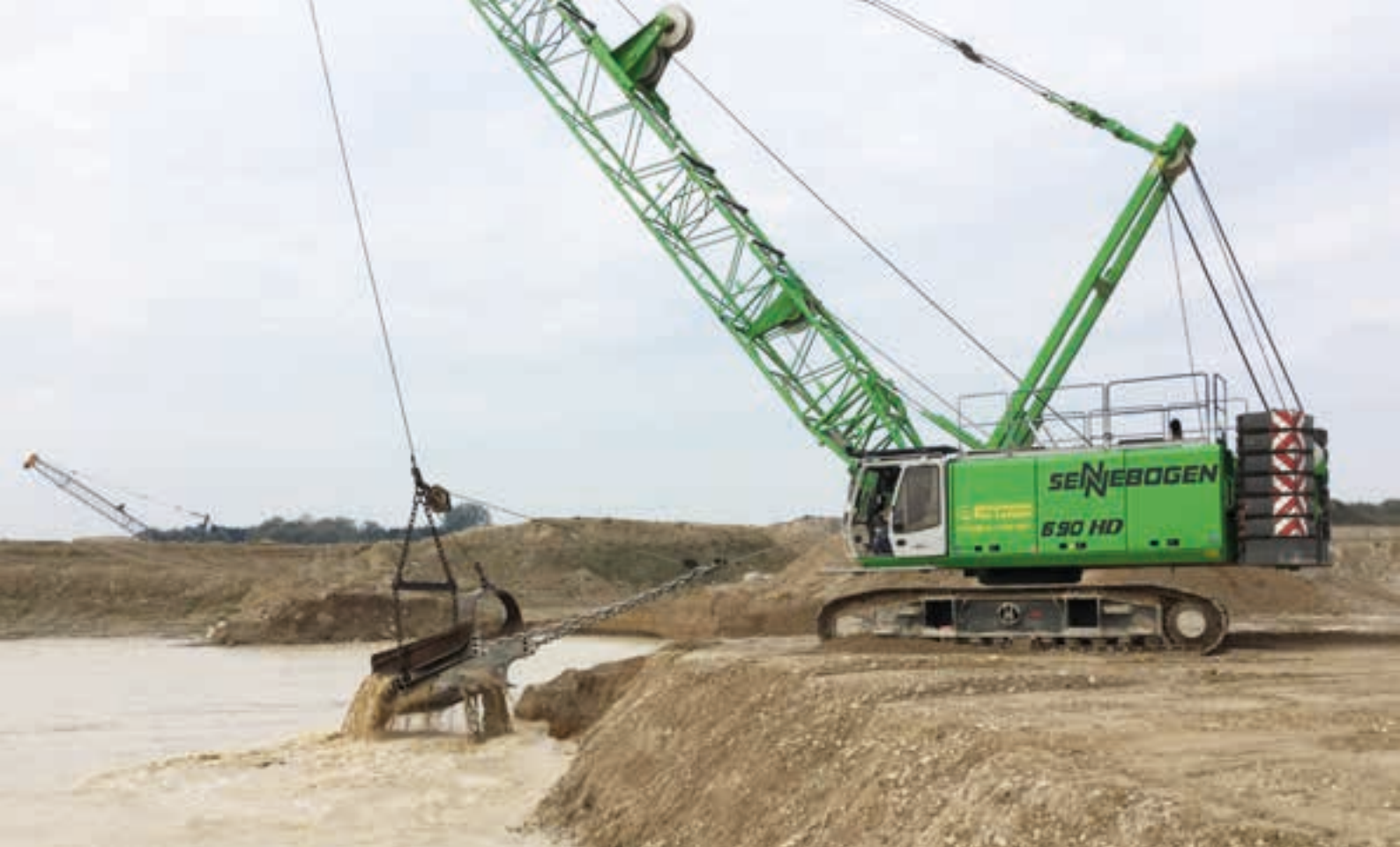
690 HD – Gravel quarrying with dragline bucket; Denmark 690 HD – Kiesgewinnung mit Schleppschaufel; Dänemark
