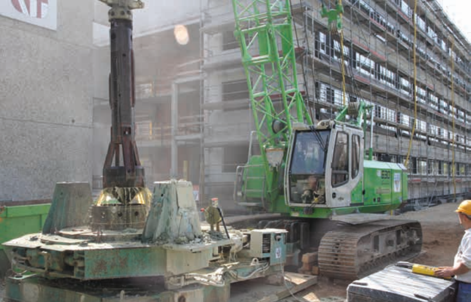
630 HD - Well digging with casing oscillator; Germany 630 HD - Brunnenbau mit Verrohrungsmaschine; Deutschland
