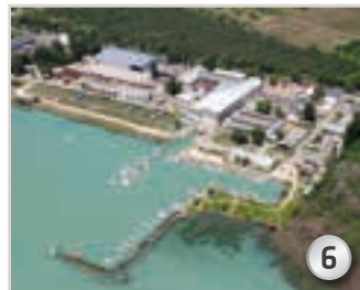
Factory Balantonyfűd/Hungary: welding/steel structures Werk Balantonyfűd/Ungarn: Schweiß-/Stahlbaugruppen
