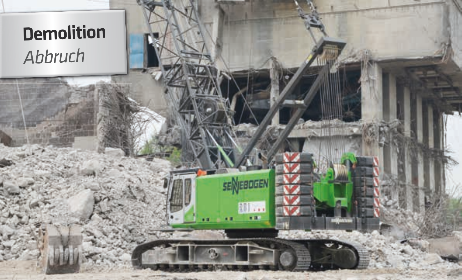
690 HD – Demolition works with wrecking ball; Germany 690 HD – Einsatz mit Abrissbirne; Deutschland
