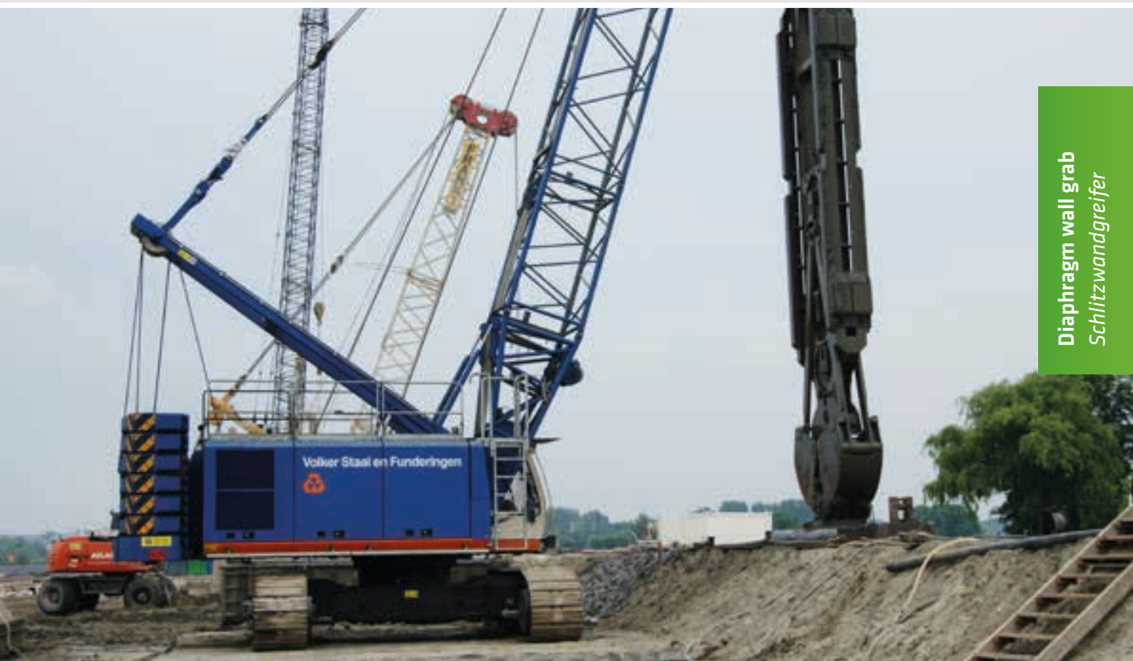
690 HD – Foundation with diaphragm wall grab; Netherlands 690 HD – Tiefbau mit Schlitzwandgreifer; Niederlande
