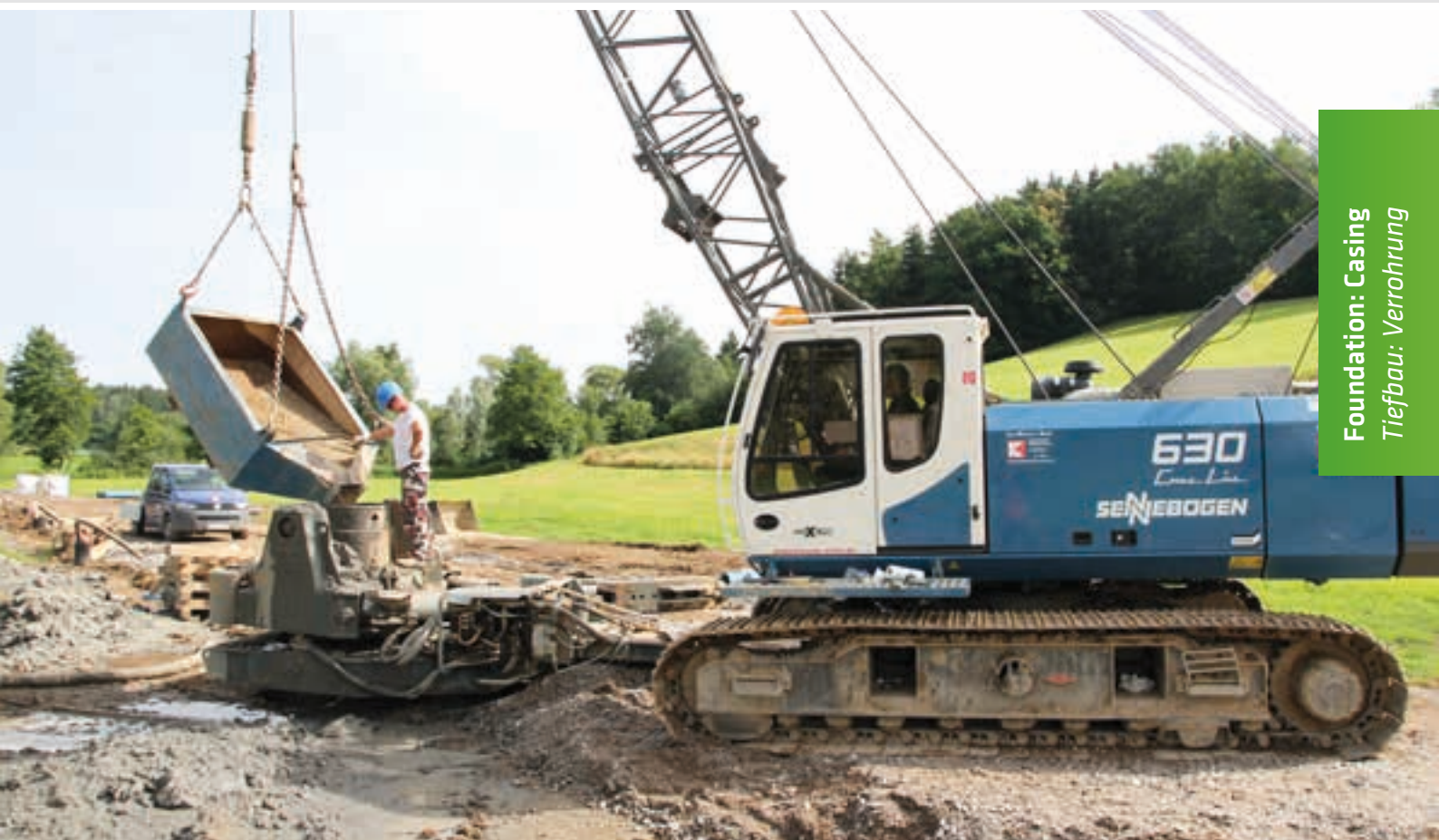
630 HD - Well digging with casing oscillator; Germany 630 HD - Brunnenbau mit Verrohrungsmaschine; Deutschland
