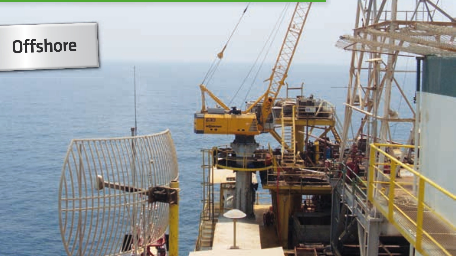
630 HD - Mounted on oil platform hoisting works for offshore application; Iran 630 HD - Hebearbeiten auf Offshore Ölplattform; Iran
