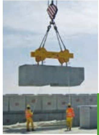
Crane operation Kraneinsatz 55
