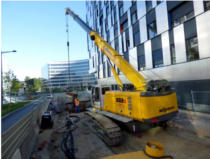
Préparation de la fosse pour construire le caisson souterrain. L'emprise de la grue est limitée entre bâtiments et rue en circulation.
