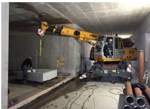
La grue compacte SENNEBOGEN 613M en intervention sur un puits à l'Hôpital de Strasbourg (crédit photo : SPEYSER)
