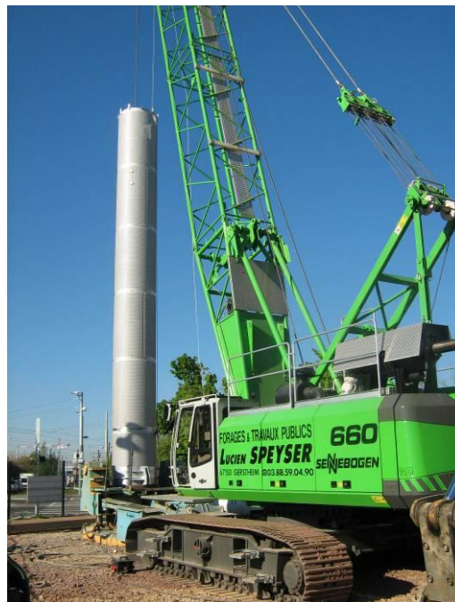
Forage de puits profonds et pose de crépine à Lingolsheim (Bas-Rhin)
