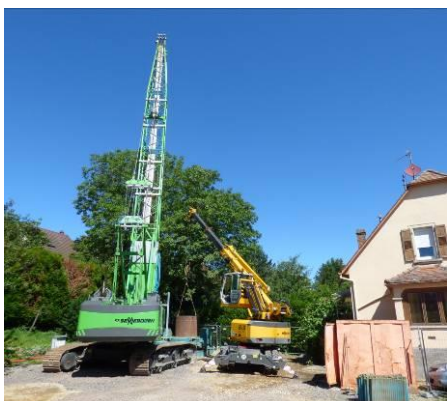
La grue télescopique SENNEBOGEN 613M est l'outil de manutention idéal sur des chantiers exigü en milieu urbain
