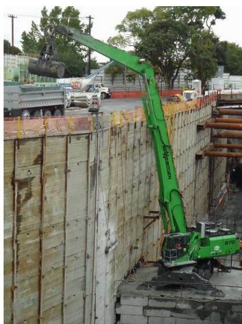
Evacuation de déblais Travaux en sous-œuvre
