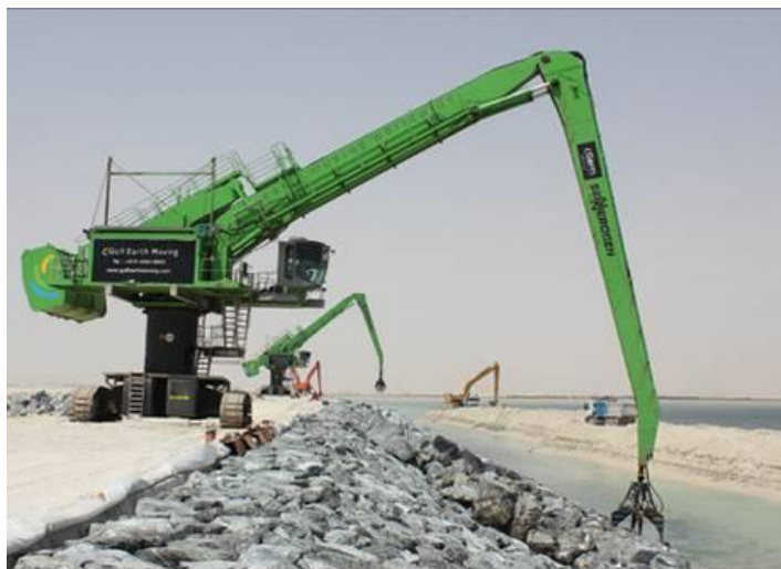
Travaux d'engrènement, renforcement de digues
