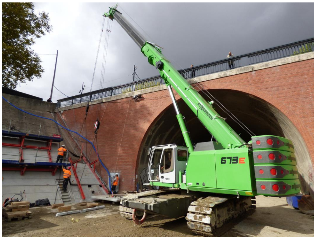
Grâce à ses deux treuils de levage et son "runner" HD de 25t de capacité, la 673R SENNEBOGEN est idéalement équipée pour positionner des éléments préfabriqués de grandes dimensions.
