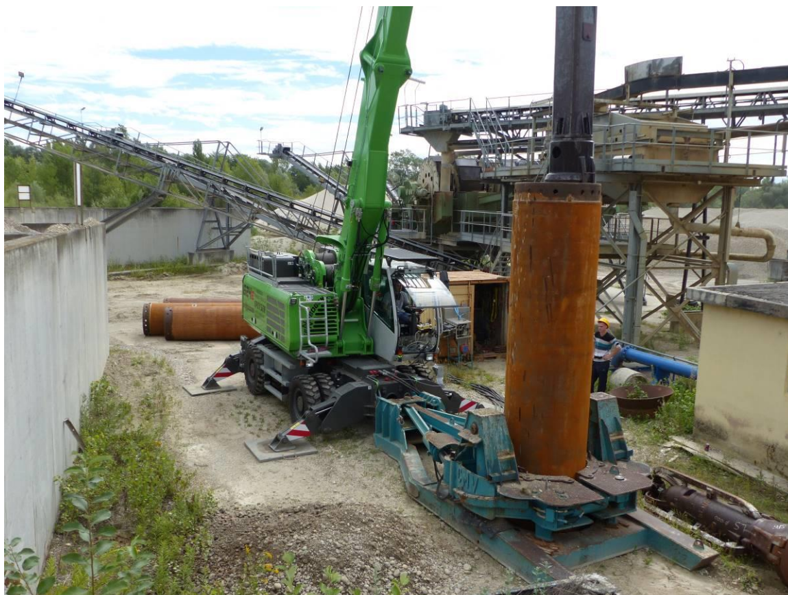
Forage de puits dans une gravière au sud de Strasbourg (Bas-Rhin)
